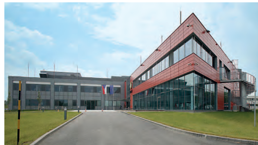
Nové sídlo BTU
